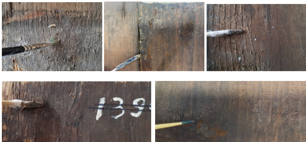
Fig. 8-12. Aspecte din timpul restaurării capacului
