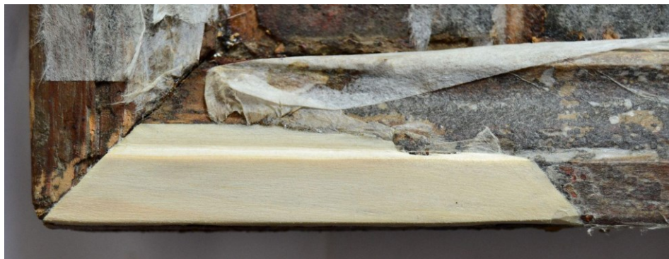
Foto nr. 14 - Completări pierderi de material lemnos
