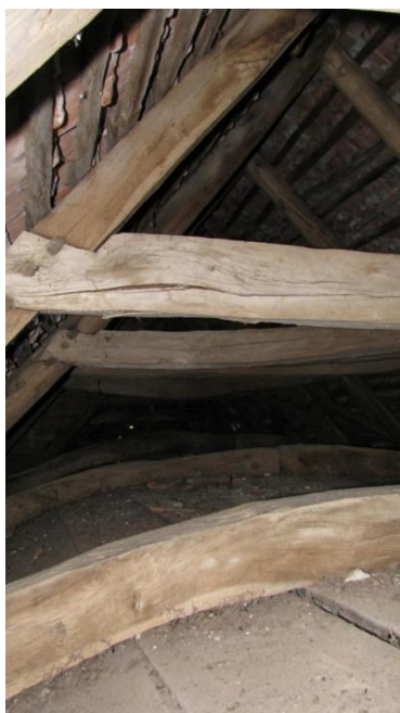
Foto 7. Șarpanta acoperișului și structura bolții naosului.
