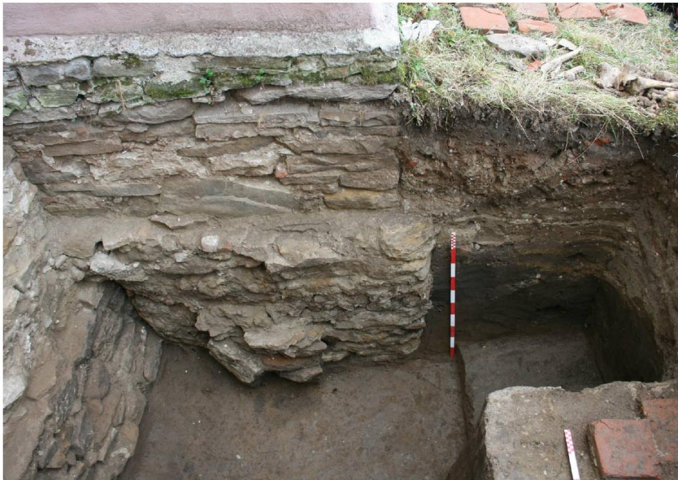
Fig. 6b. C2 – detaliu cu fundațiile laturii de nord a navei și a contrafortului adosat
