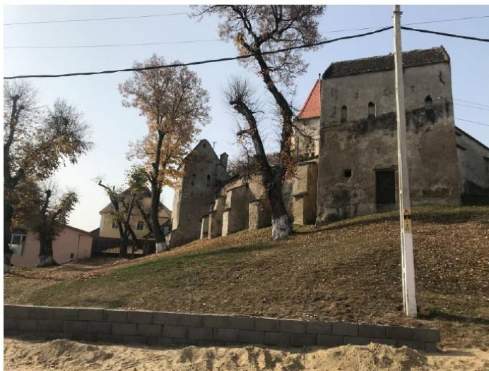
Fig. 2. Șaroș pe Târnăvă - vedere dinspre est
