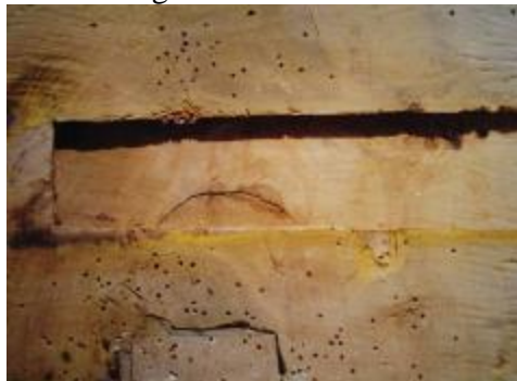
Foto 6. Detaliu verso după demontarea traversei
